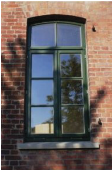
Fensterkante: Fadura plus mit einem U_f -Wert von 0,94 \text{ W}/(\text{m}^2 \times \text{K})
