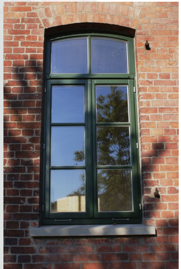
Fensterkante: Fadura plus mit einem Uf-Wert von 0,94 W/(m 2 x K) laut Prüfbericht Rosenheim.
