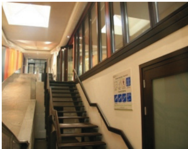
Fadura Holzkantel für Fenster und Türen im Schwimmbad und proGOODWOOD Thermobuche für die Treppenanlage
